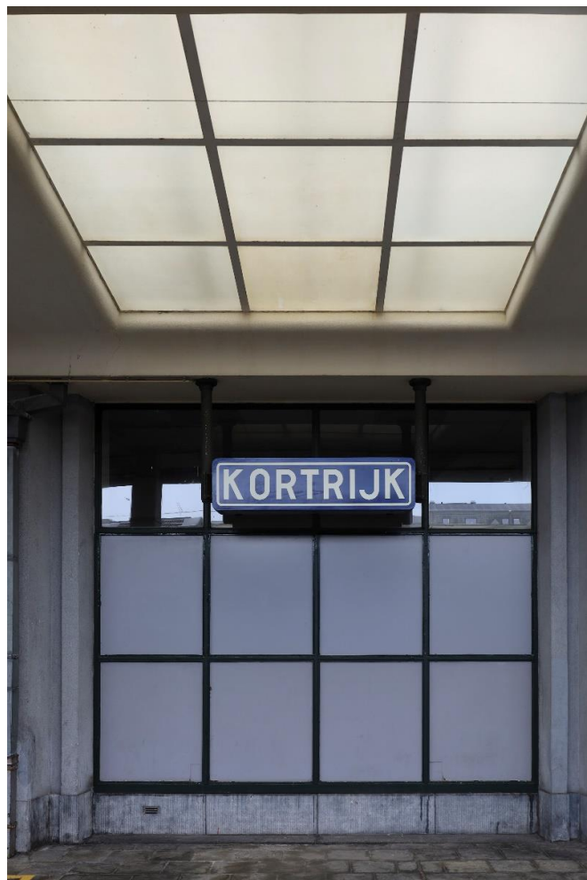
Figuur 40: Detail van de perronoverkapping en de achtergevel 2022 – bron: fotocollectief PxL, Luc Michiels
