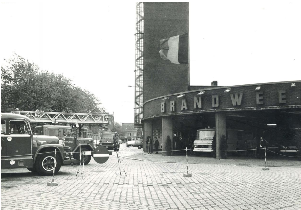
Figuur 11: Brandweerkazerne gebouwd in 1940, vandaag beschermd als monument - bron beeldbank Kortrijk
