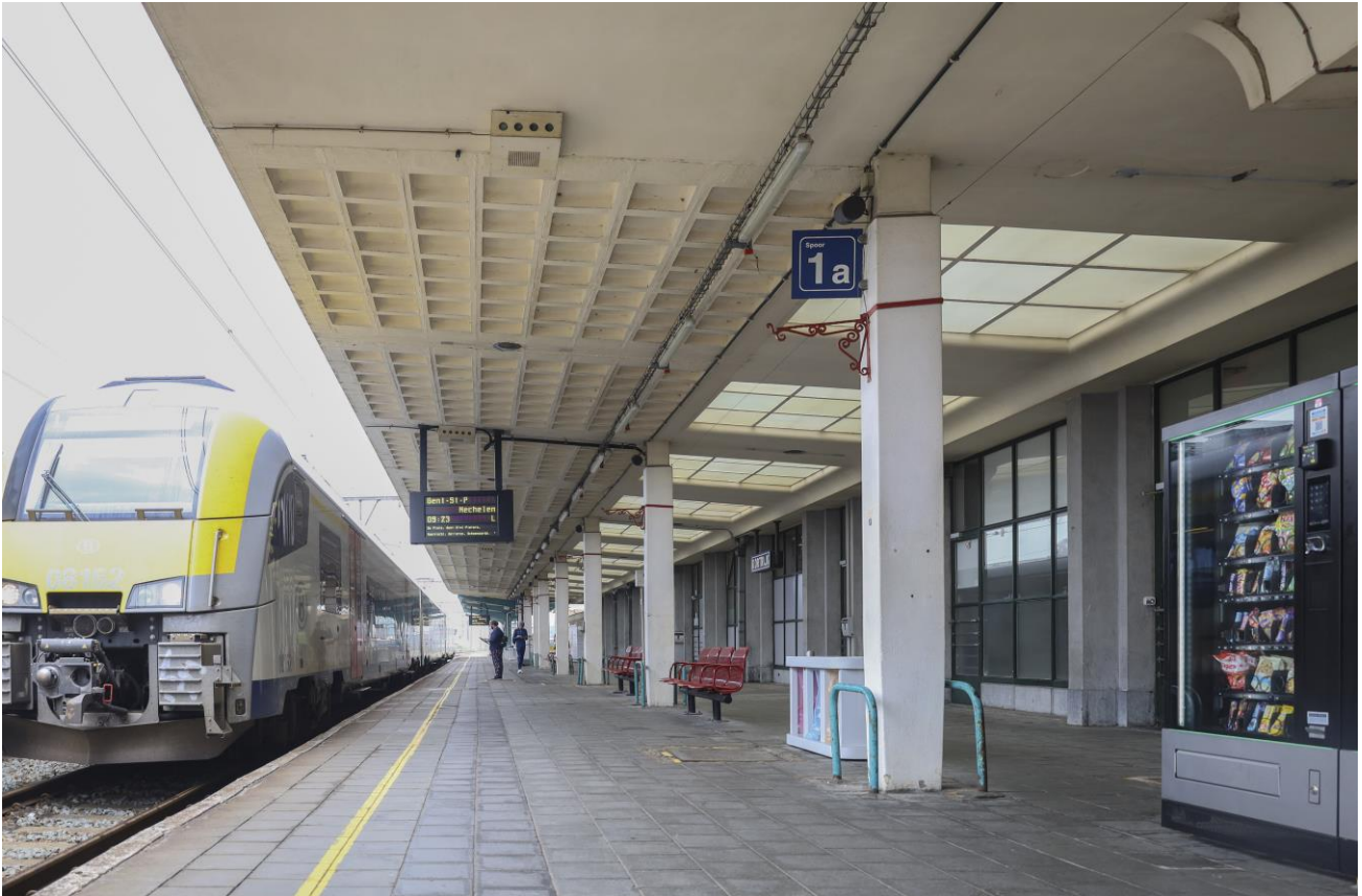
Figuur 39: de betonnen luifel aan de spoorzijde 2022 – bron: fotocollectief PxL, Luc Michiels
