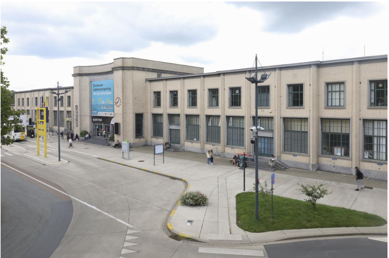
Figuur 37: zicht op de voorzijde van het stationsgebouw 2022 – bron: fotocollectief PxL, Luc Michiels
