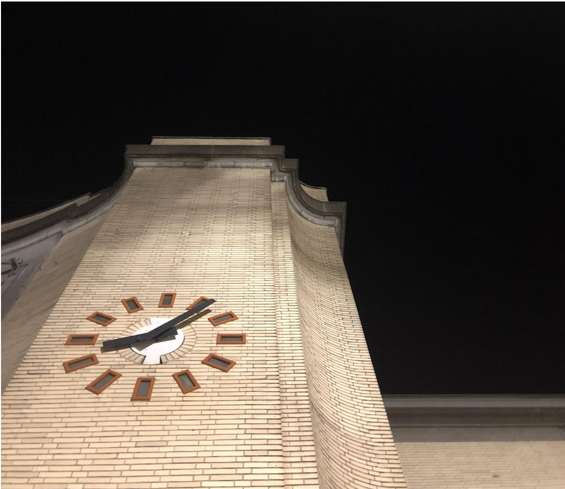
Figuur 12: detail van de fifties stationsklok en het metselwerkverband in gele baksteen – bron: fotocollectief Pxl
