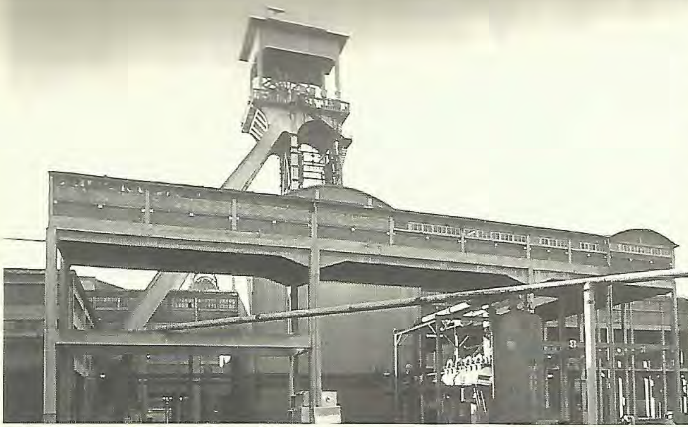
Eisden: betonnen schachtbok
