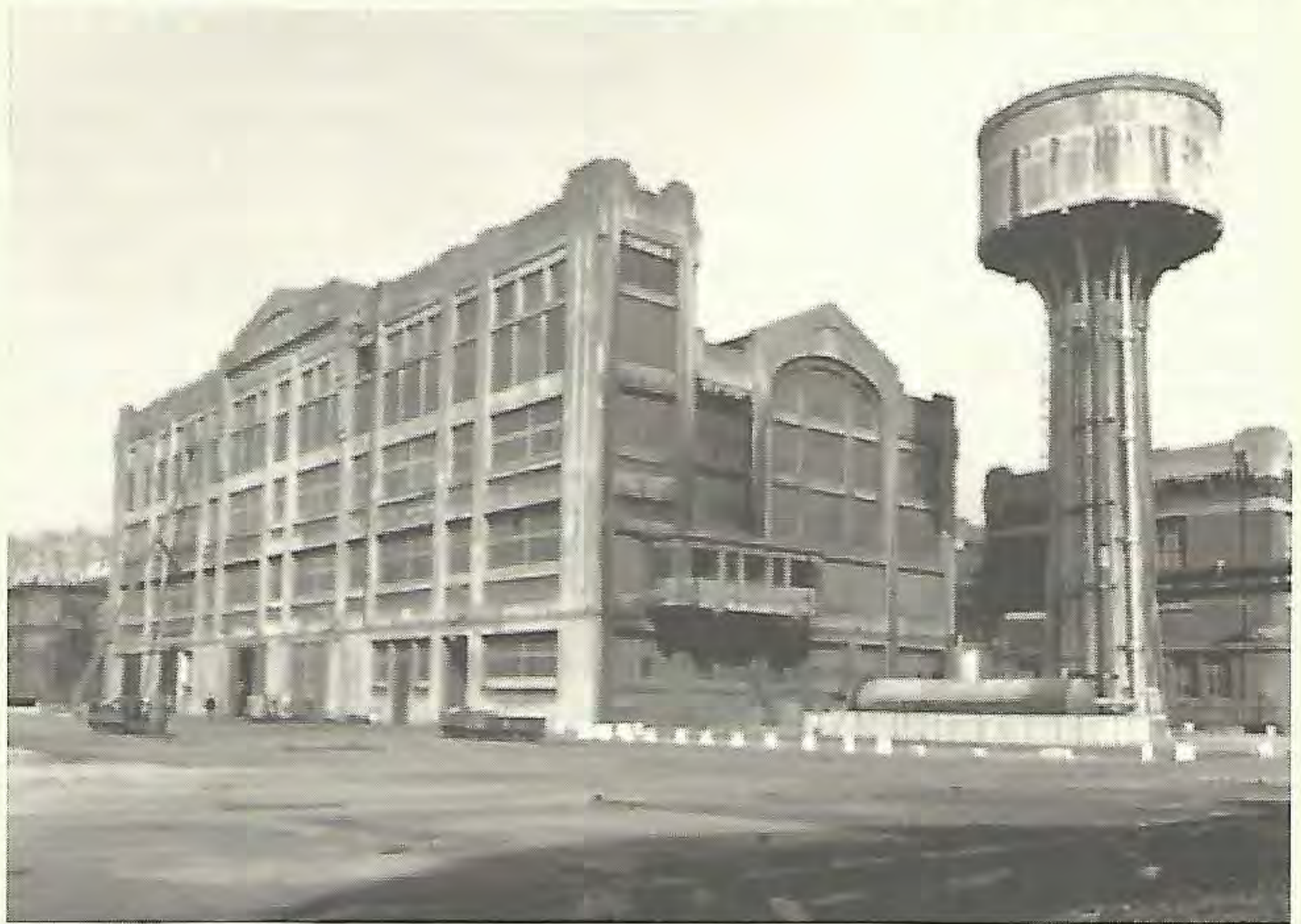
Waterschei: centrale en ketelhuis
