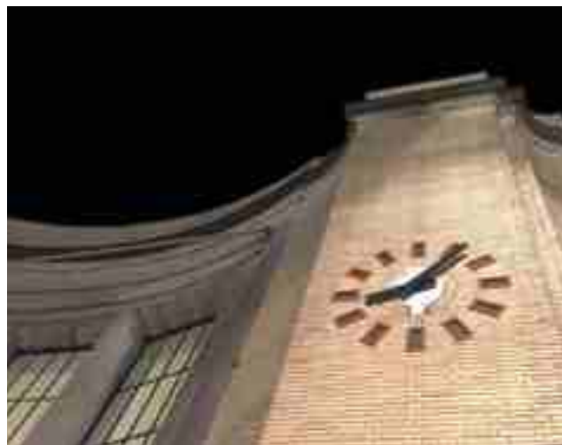
Afgeschuinde penant aan de voorgevel met uurwerk (Foto Hannes Pieters)
