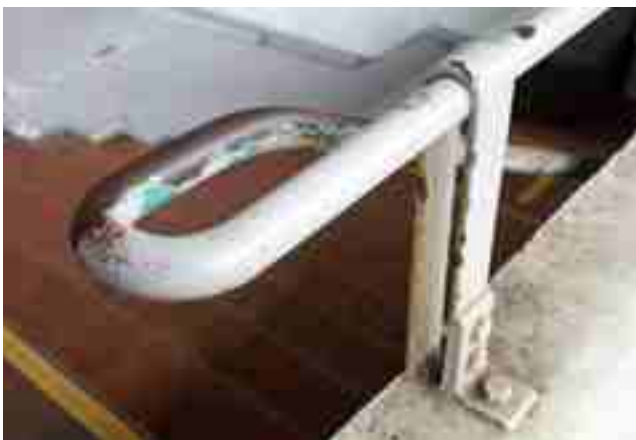
Detail trapleuning: de initiële groenblauwe kleurstelling was ook hier aanwezig, 2021. (Foto Luc Michiels)
