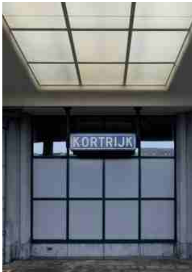
Detail van de perronoverkapping en de achtergevel. (Foto Luc Michiels)
